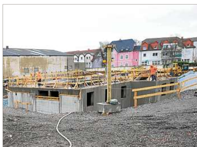
Der Keller des neuen Schmallenbach-Hauses ist bereits fertig. Damit liegt der Bau im Zeitplan. ■ Foto: Grzelak
