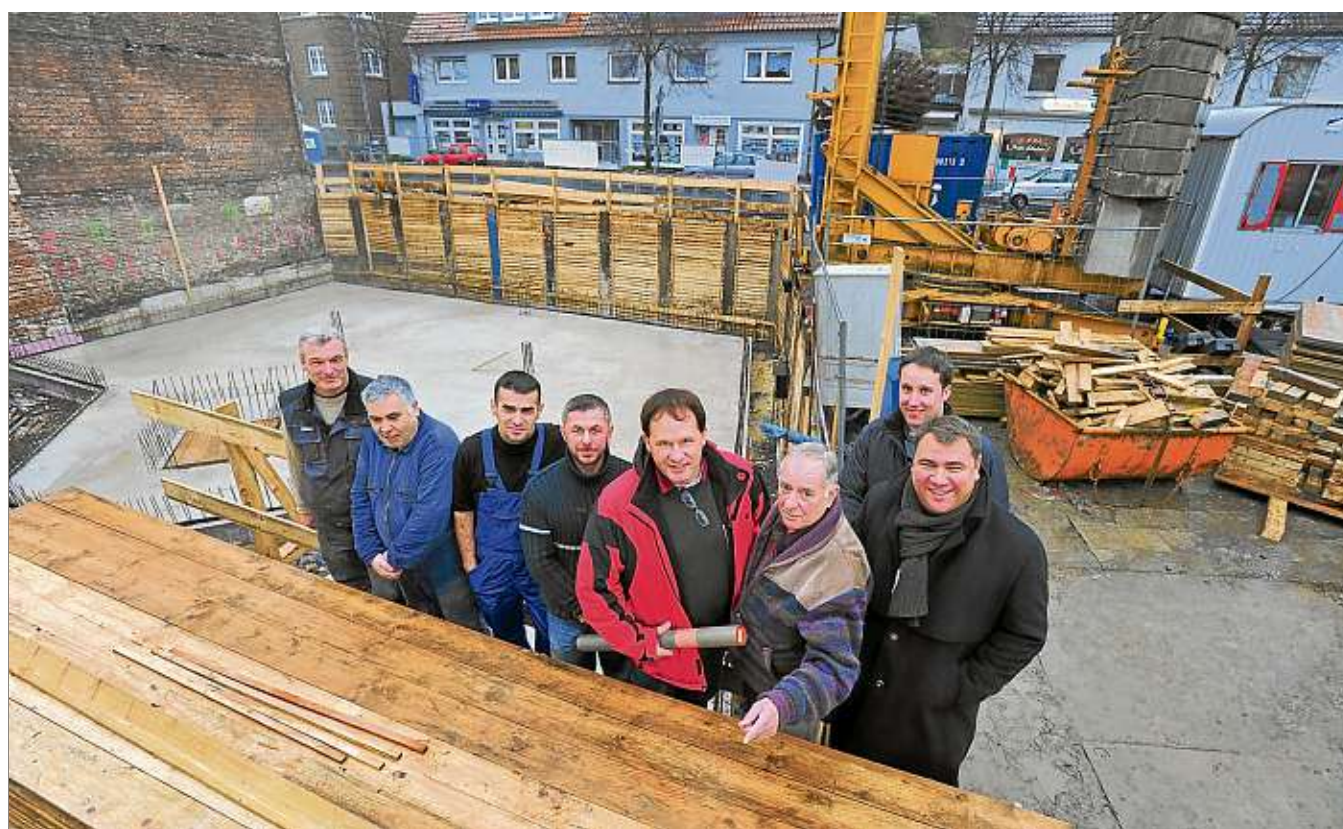
Die Bodenplatte ist gegossen, ab Januar soll der Neubau des Bauvereins darauf geschwind in die Höhe wachsen. Geschäftsführer Martin Kriemann (r.) und Aufsichtsratsvorsitzender Heinz Luig (3.v.r.) lobten gestern die bereits geleistete Arbeit des Architekten Ulrich Bräckelmann (4.v.r.) und des Bautrupps aus Unna. ■ Foto: Grzelak
