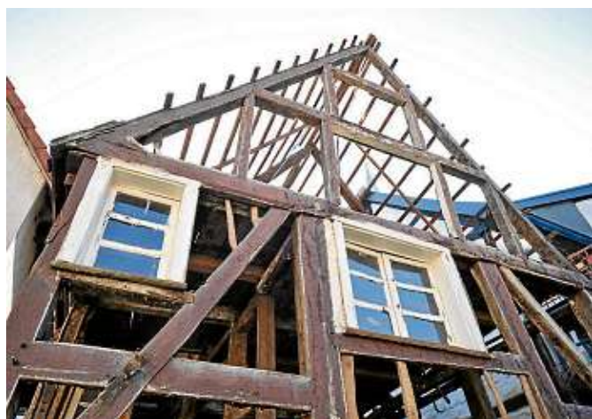
In zwei Abschnitten wird das Skelett des alten Fachwerkhauses am Güldenen Trog 2 ab heute abgebaut (im Bild die rückwärtige Ansicht).
