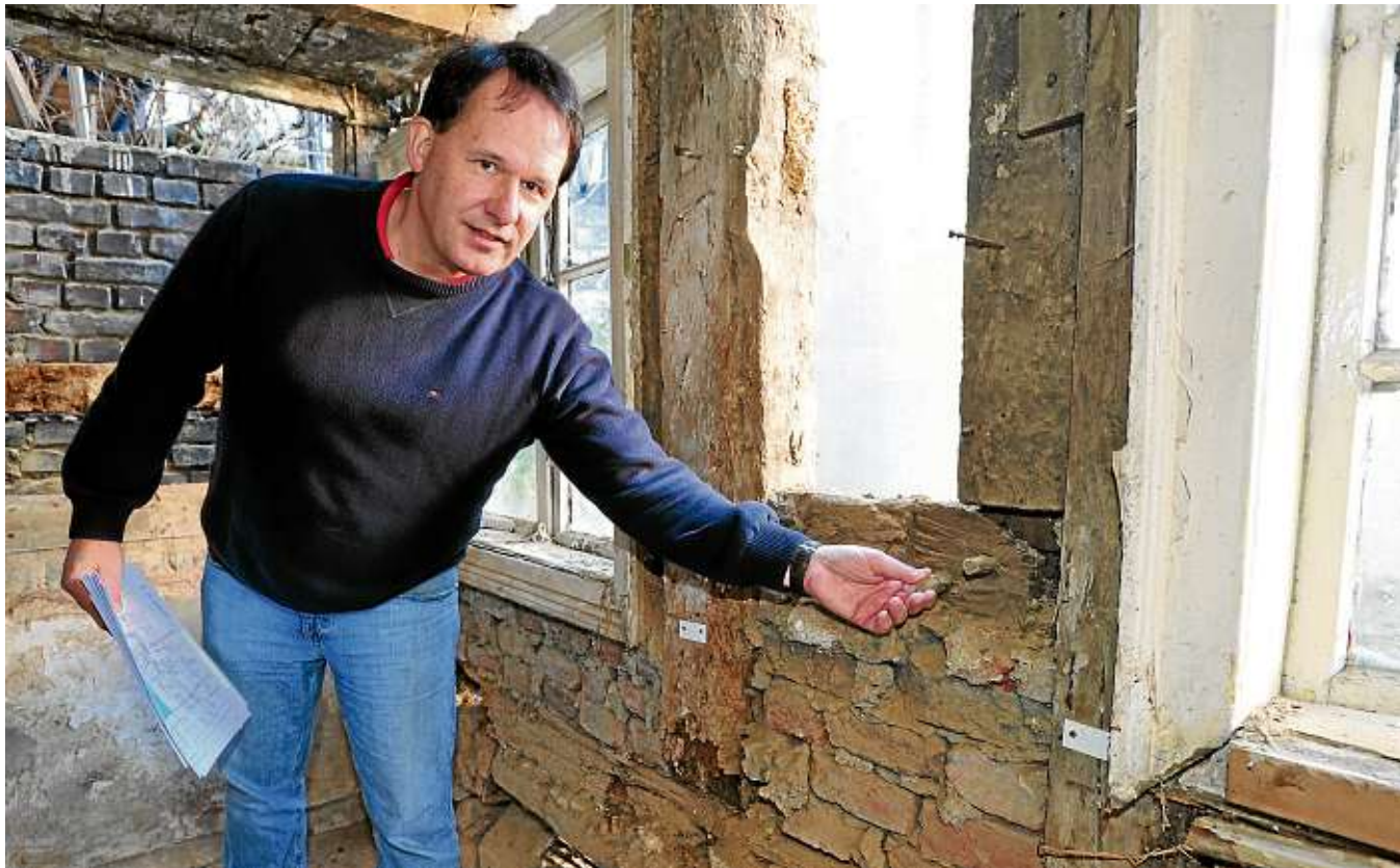
Architekt Ulrich Bräckelmann zeigt einen der gut erhaltenen Holzstifte, die als Nägel fungieren und die Balken zusammenhalten. Die beiden weißen Plättchen dienen der Markierung – damit beim Wiederaufbau alles wieder seinen richtigen Platz findet. ■ Fotos (3): Grzelak
