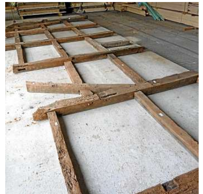
Auf einem sogenannten Schnürboden legen die Zimmerleute aus Voßwinkel das Gebälk des Fachwerkhäuses erst zusammen, um es auf Passgenauigkeit und Schäden zu begutachten. Passt alles, wird die liegende Wand wieder auseinandergelöst, nach Unna gefahren und dort neu aufgestellt. Foto: Bräckelmann
