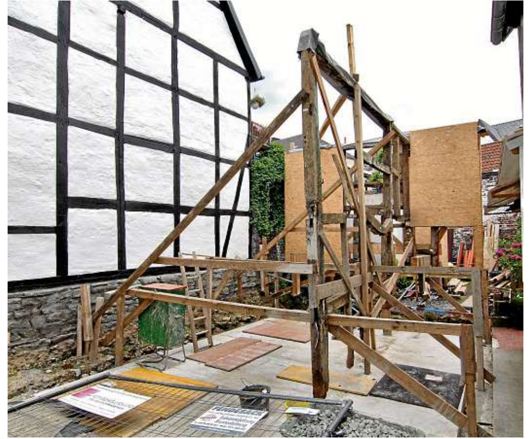
Die Baulücke am Guldernen Trog sieht abenteuerlich aus: Nur noch eine Seitenwand steht, weil die Denkmalbehörde dies verlangt. Wie sehr die Planer puzzeln müssen, zeigt die virtuelle Ansicht des Fachwerkhäuses mit all seinen Balken. Foto/Grafik: Hennes/Bräckelmann
